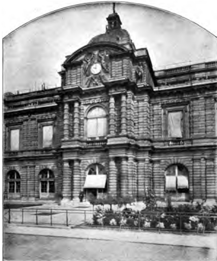
Palais du Luxembourg. — Façade sur le Jardin.
